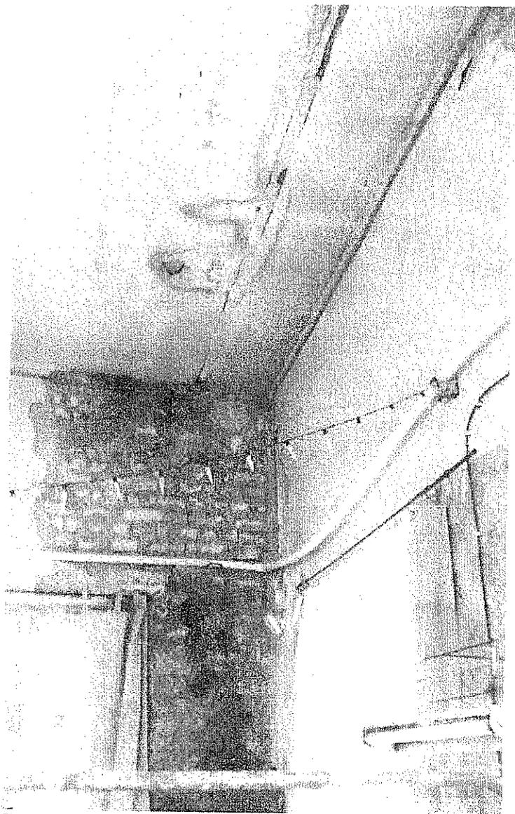
Следы протечек атмосферных осадков на стене здания на плитах покрытия; разрушение (отсутствие) штукатурного слоя стены здания  $S_{\text{общ}}=1,8\text{ м}^2$  в осях А-4.
